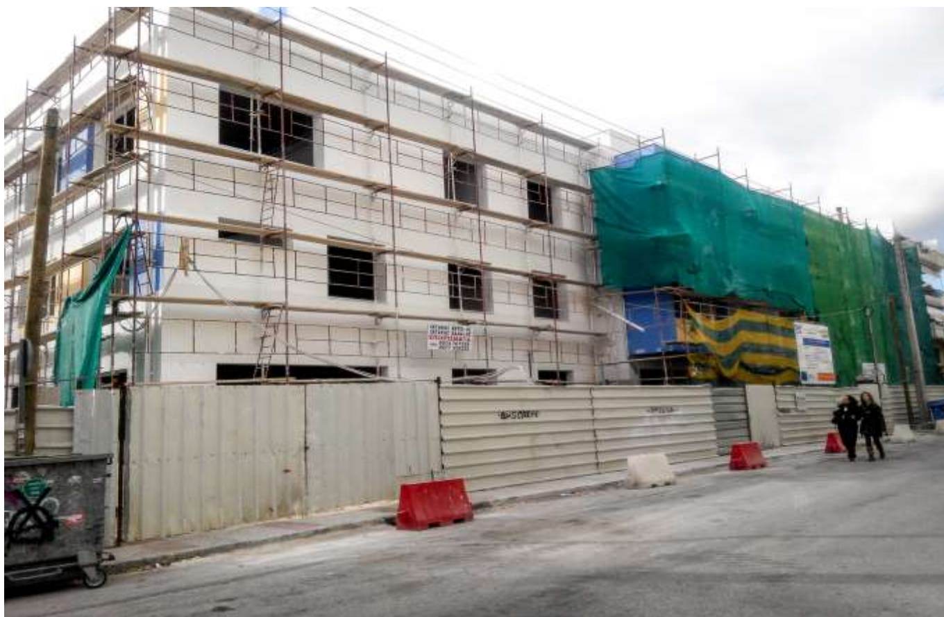
Κατασκευή του νέου σύγχρονου Ειδικού Δημοτικού Σχολείου στη συμβολή των οδών Καππαδοκίας και Επταπυργίου στο Ίλιον
