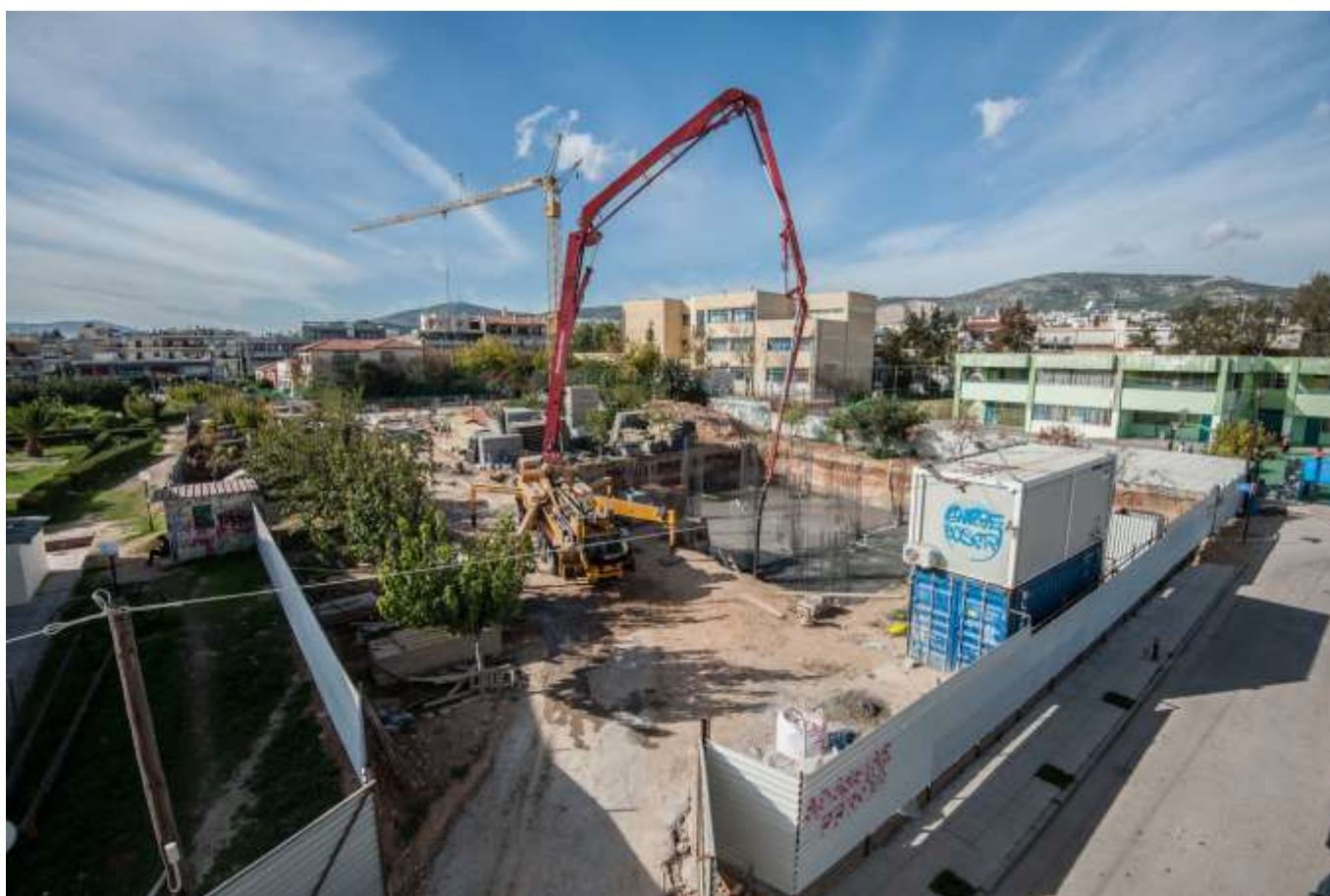
Ανέγερση του 15 ου και 30 ου Νηπιαγωγείου Ιλίου
