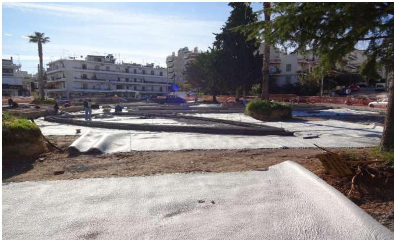
Ανακατασκευή του Κόμβου Ιλίου (πλατεία «Καπετάν Ζαχαριά»)
