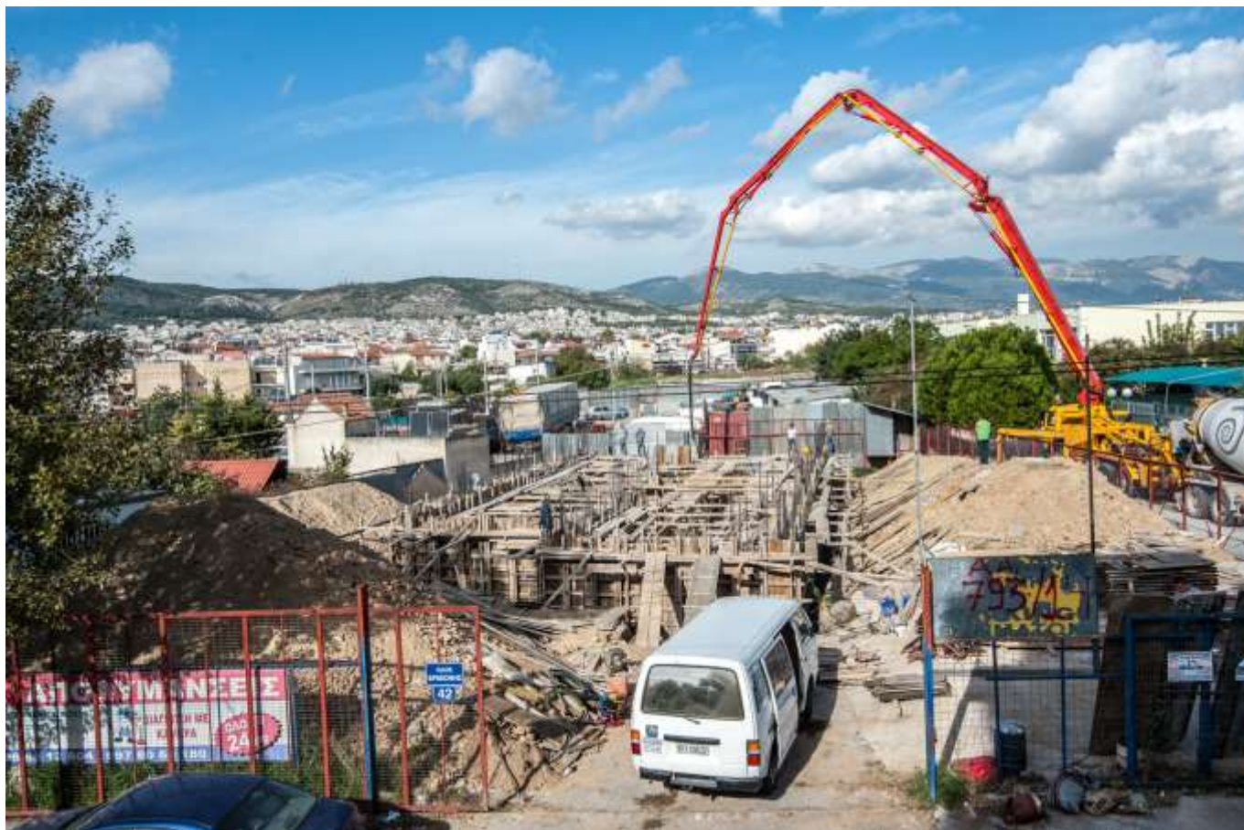
Ανέγερση του 28 ου Νηπιαγωγείου Ιλίου
